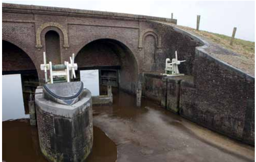
Zodra het lukt om met sluisen overtollig water te lozen en te voorkomen dat het nog binnenkomt, kunnen grotere gebieden geschikt gemaakt worden voor landbouw. Voorbeeld: monniken bouwden rond 1250 spuisluis bij Aduardersluis (Gr.).
