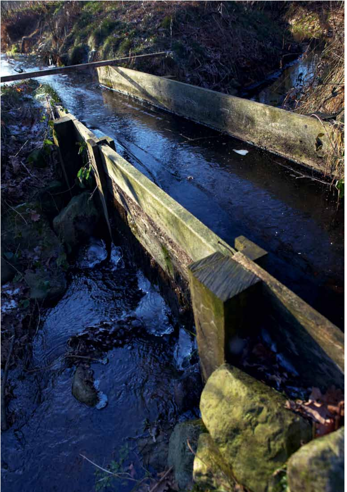
Onderdeel van het Waterpark: een aquaduct waar twee lokale beken elkaar kruisen.
