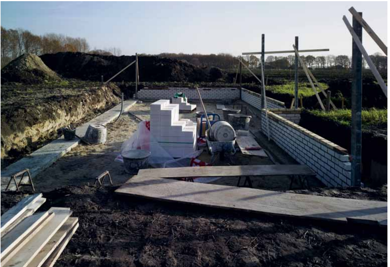
Fundament voor een van de 62 nieuw te bouwen koloniewoningen. De erfpacht daarvan wordt waarschijnlijk de grootste inkomstenbron.
