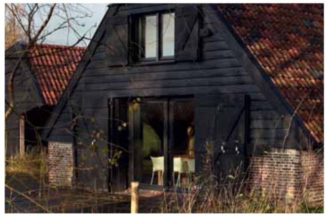
Gerestaureerde schaapschuur van Landgoed Scherpenzeel waar Meta Daniëls kantoor houdt: "Recreatie zal nog belangrijker worden."
